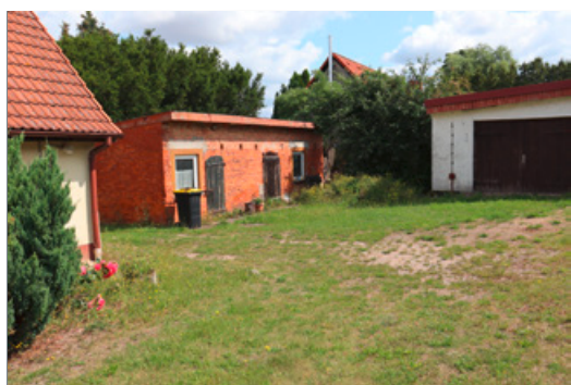
Werkstatt und Garagengebäude
