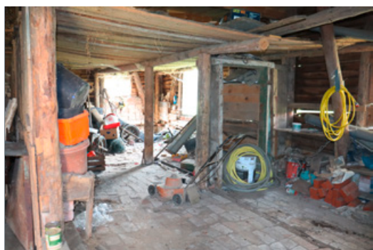
Scheune von innen
