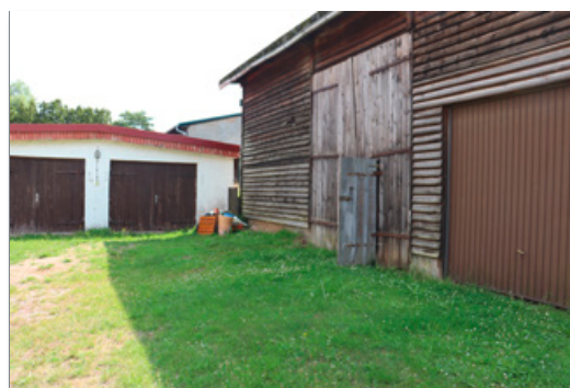
Garagengebäude und Scheune
